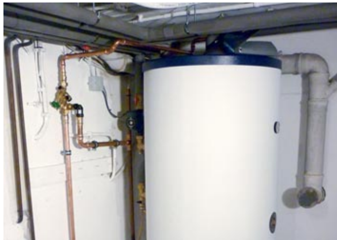
Solarthermie als Erweiterungsoption: Der neue 380-Liter-Solarspeicher
